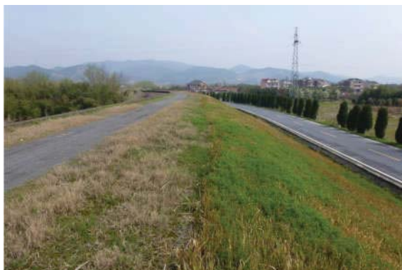
图五 城墙外侧坡度实景图
