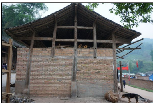
图6 砌块维护的木结构房屋
