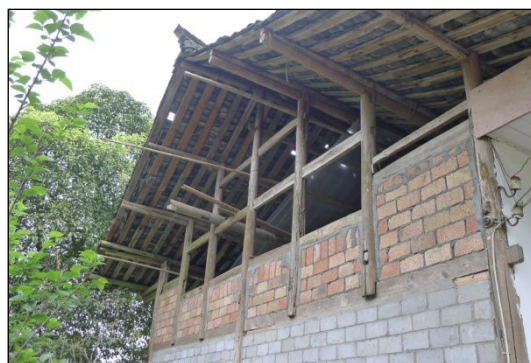
图 13 墙体材料由黏土砖和灰砂砖组成
