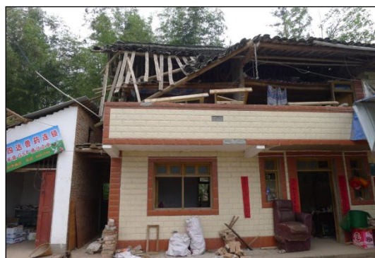
图 14 下部为砌体结构上部为木结构
