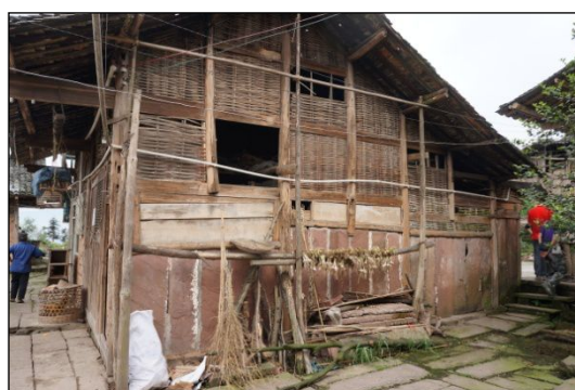
图 5 石板维护的木结构房屋
