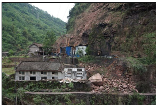
图 17 高山滚石砸毁房屋案例
