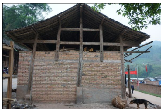
图 4 木板维护的木结构房屋
