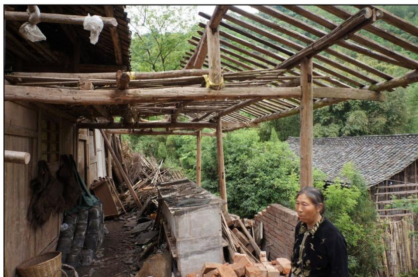
图 3.1-4 屋面瓦片脱落
