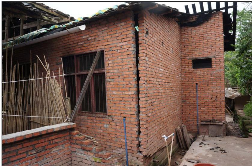
图 2.3-2 图中砌体墙在地缝错动时，不能适应变形，导致两侧墙体拉裂。
