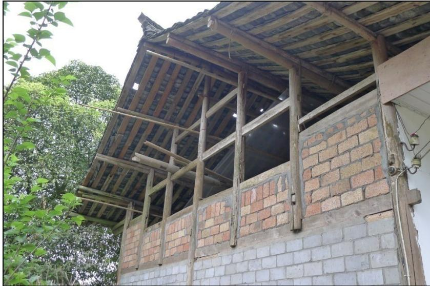
图 4.2-1 房屋材料包含木材、粘土砖、灰砂砖
