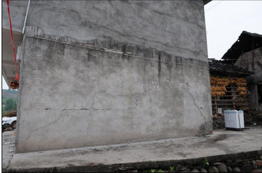
图 2.1-1 该楼结构在地震中未见明显破坏，在震前已出现沉降裂缝，前后高差相差约 10cm。
