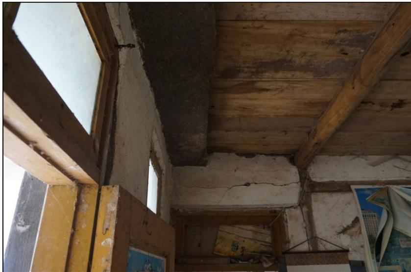
图 4.2-2 楼板一部分用混凝土一部分用木楼板
