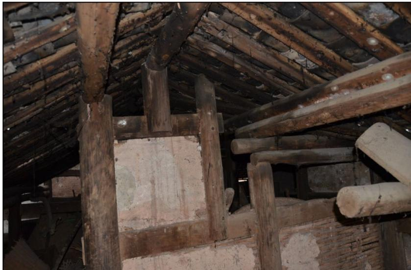
图 3.1-5 木结构节点拉脱
