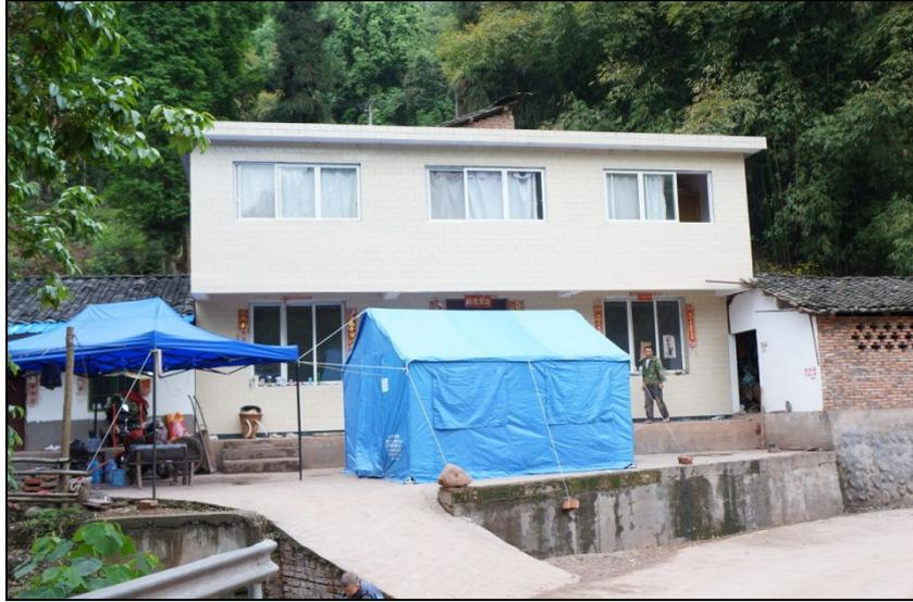
图 3.4-2 汶川地震后建设的砌体墙混凝土楼盖结构
