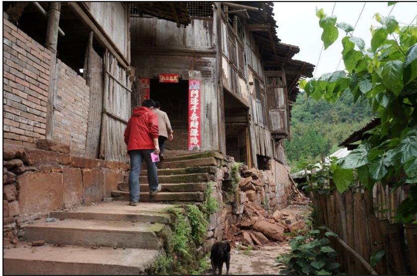
图 2.4-1 房屋前后存在高差，前部垫高积层松散，在地震中垮塌。
