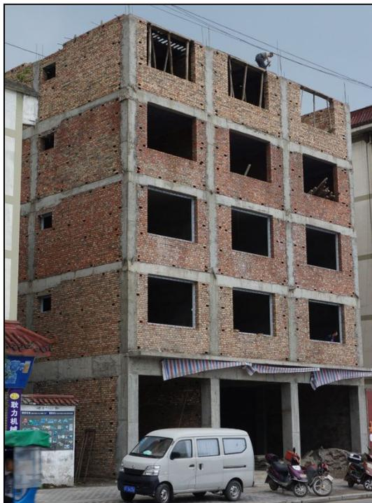
图 3.5-1 框架和砌体混合结构
