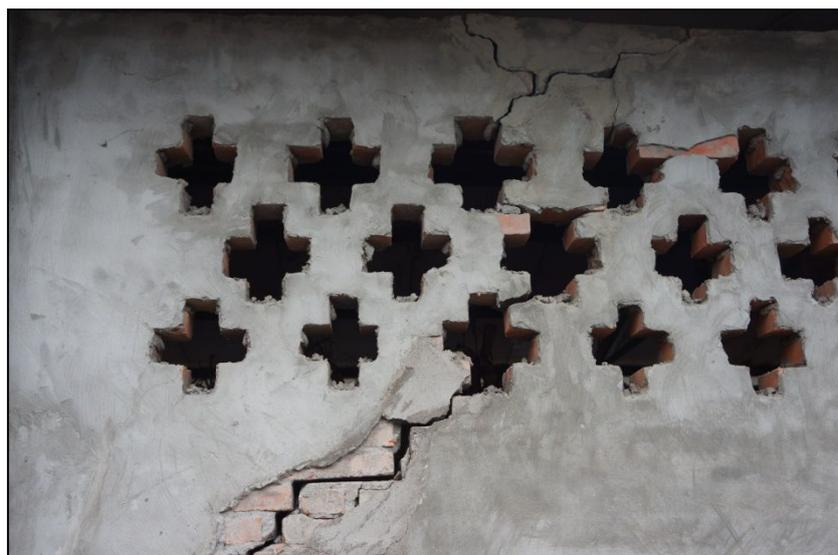
图 3.4-5 砌体墙采用露空砌筑发生破坏
