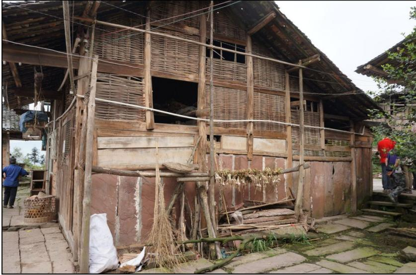
图 3.2-2 木柱-石板组合结构
