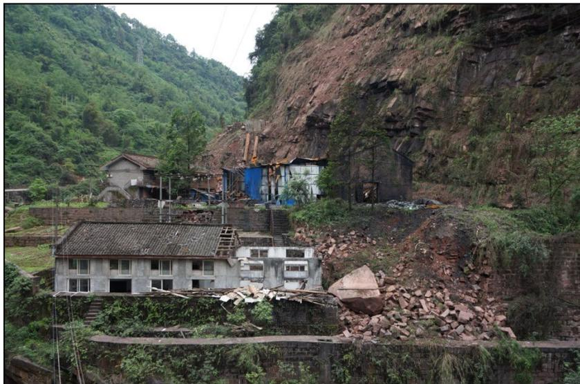
图 2.2-1 该楼右侧悬崖高 150 米，崖壁未作防护处理，房屋在震中被滚石砸毁。
