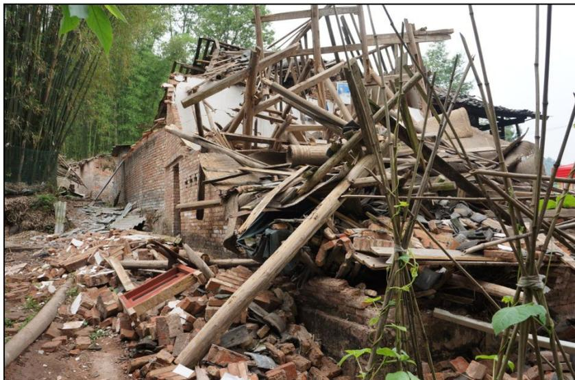
图 3.2-4 木柱-砌体结构整体倒塌
