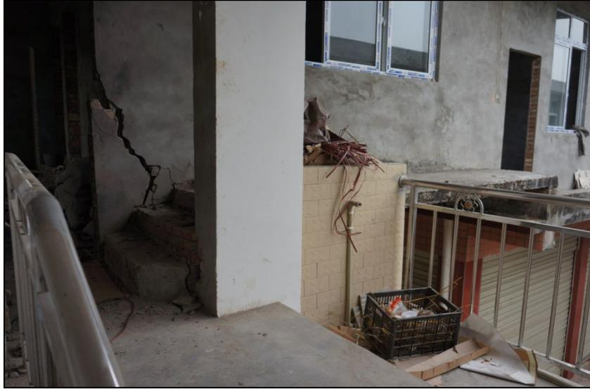
图 4.5-2 新旧房屋间未设置抗震缝震害
