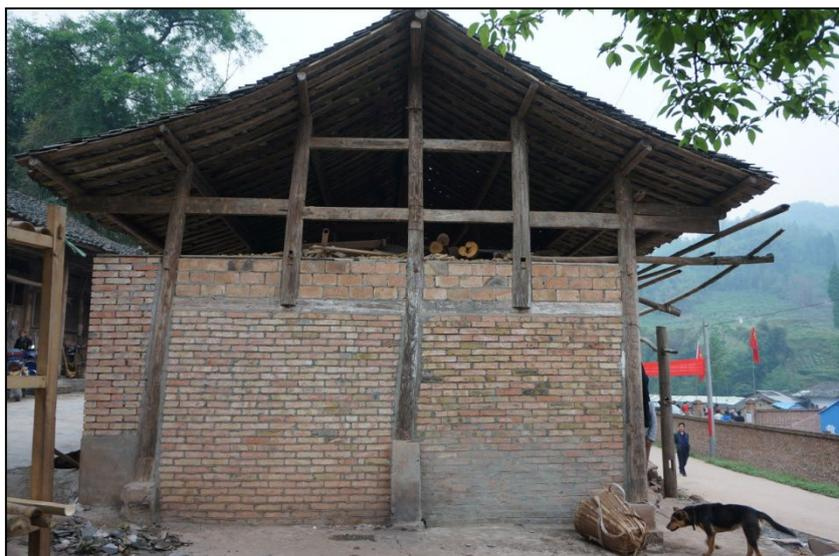
图 3.2-1 木柱-砖组合结构
