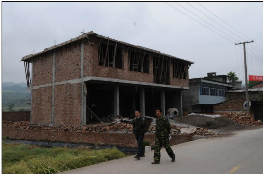
图 5.1-1 设置构造柱和圈梁的砌体结构农民自建房
