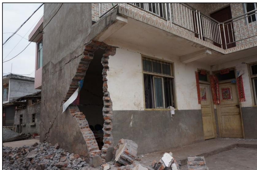
图 3.4-4 角部未设构造柱墙体坍塌
