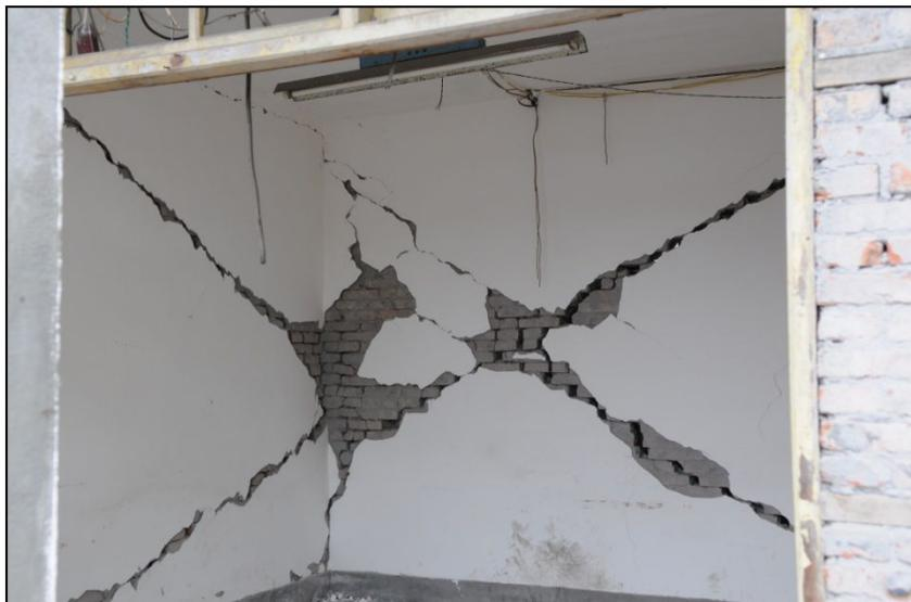
图 3.4-3 砌体墙出现 X 型剪切裂缝
