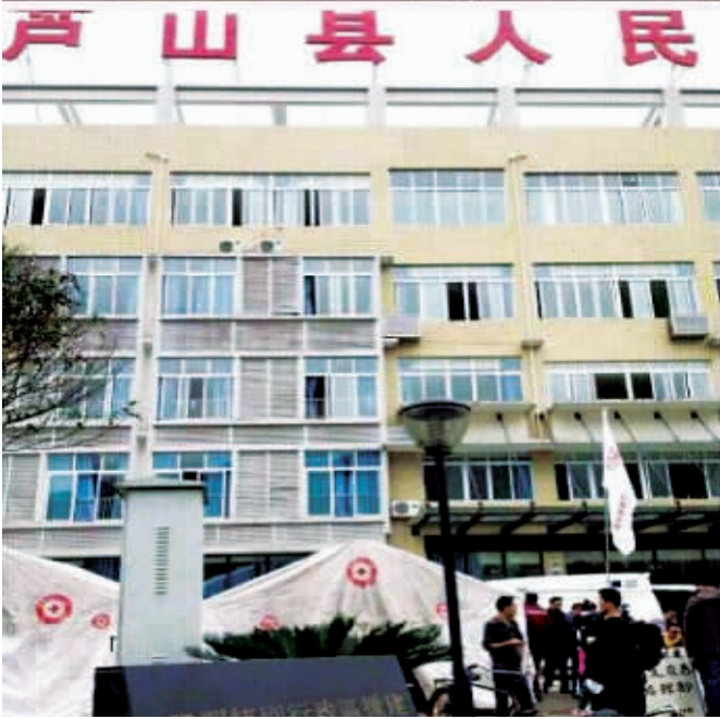
这组对比照片在网上引发热议。专家表示,上图的隆兴学校“是抗震结构,这样破坏,符合预期”,而下图的人民医院“是隔震结构”,因此才能完好无损。
