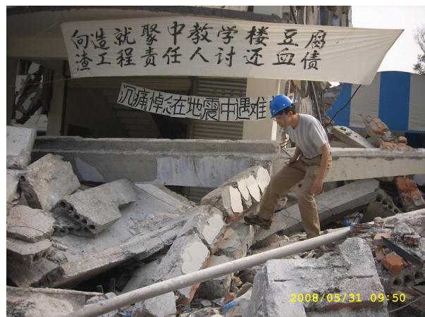
图一 聚源中学倒塌楼现场
