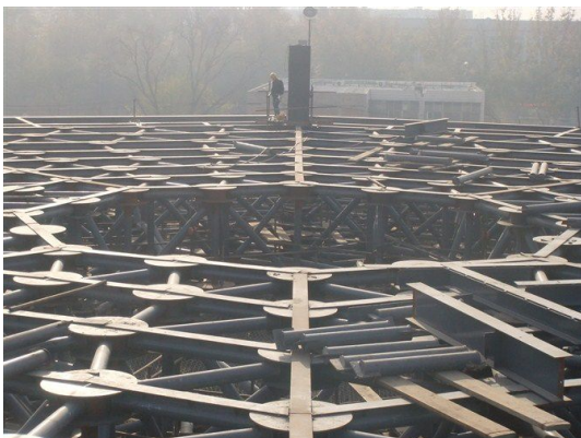
图 12 入口平台安装完毕后情况
