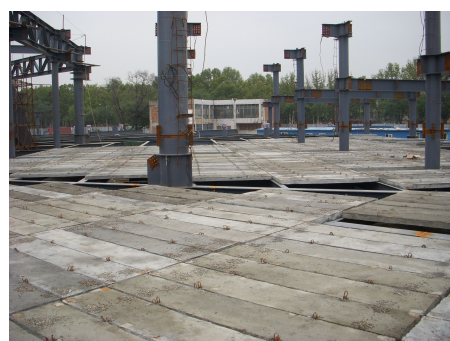
图 14 预制楼板安装情况
