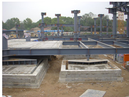
图 9 基础施工完成情况
