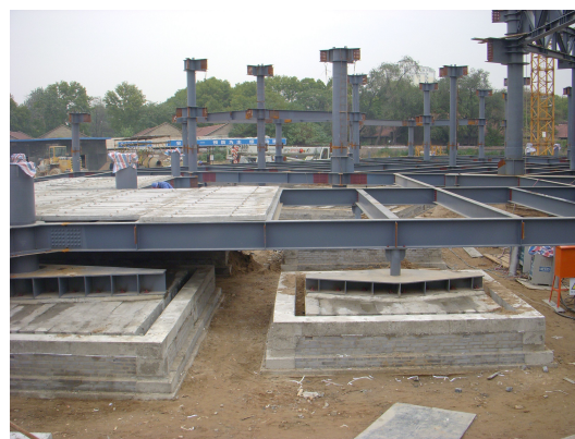
图 15 基础施工完成情况
