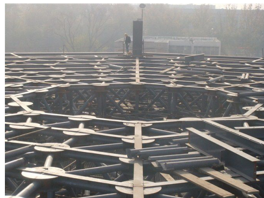
图 17 入口平台安装完毕后情况
