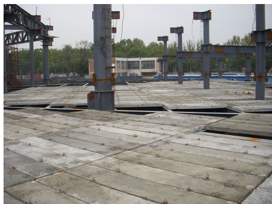
图 18 预制楼板安装情况
