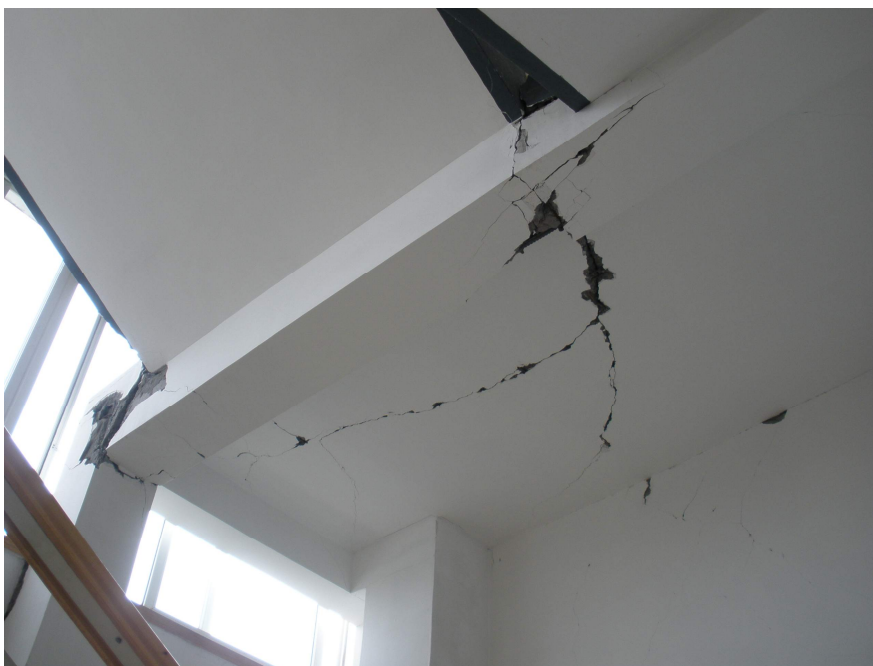
图 5.28 楼层中部休息平台被拉裂，梯梁在中部发生剪切破坏
