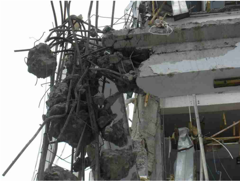
图 5.17 预制框架楼中梁柱节点配筋情况
