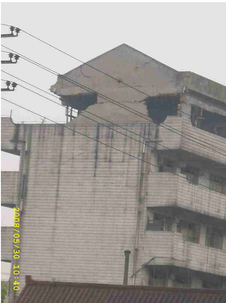
图 5.24 六层砌体结构上加建一层，地震中两侧墙体脱落
