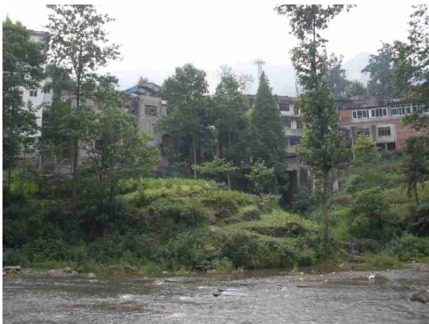
图 4.9 距离地面错动位置几百米外的几栋底框建筑物保持完好，但该镇多数建筑损毁
