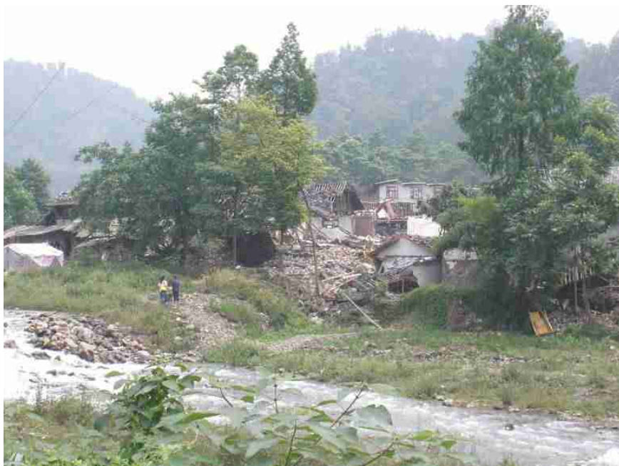
图 4.2 该场地原为缓坡地段，地震时图中右侧地面升高两至三米，变化处的民居全部损毁，两侧民居多发生屋面瓦震落现象
