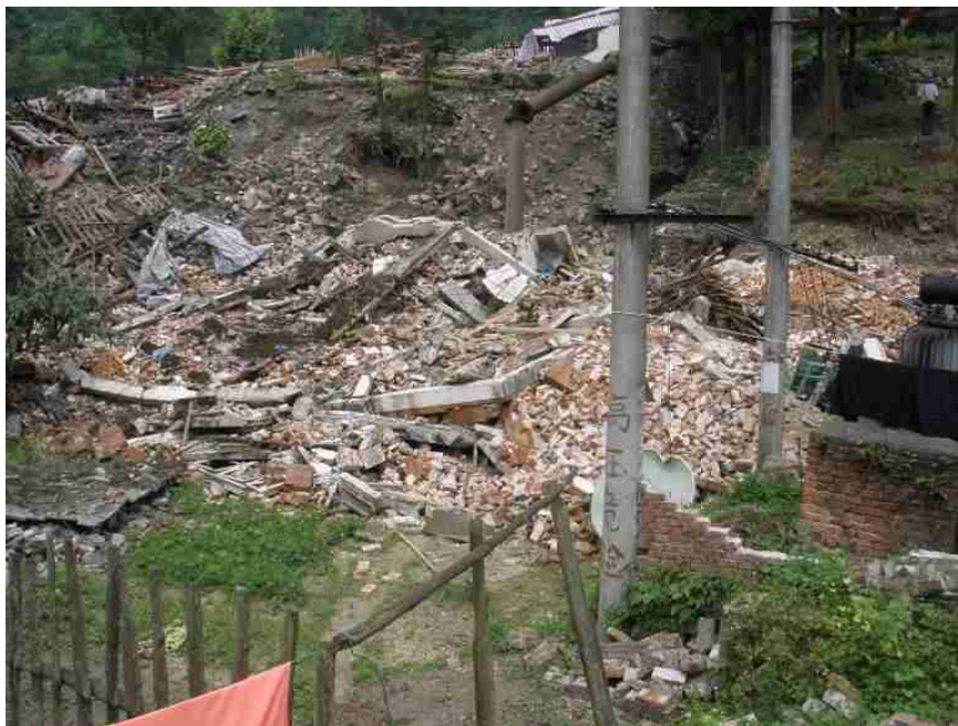
图 4.3 一栋位于地面急剧变化处的三层建筑物，结构无法承担地形变化而粉碎性破坏，
