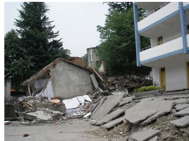
图 4 地面位错造成房屋倾斜
