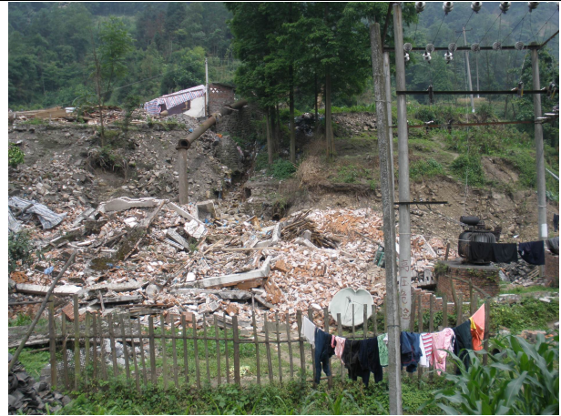
图 3 地面位错造成房屋损毁
