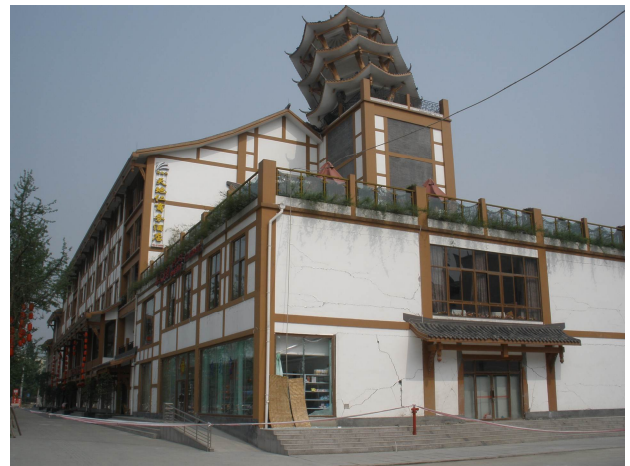
图 5 都江堰某框架楼震害
