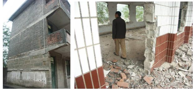
图 6 不同材料的墙体 图 7 空心砌块建成的教室拆除
