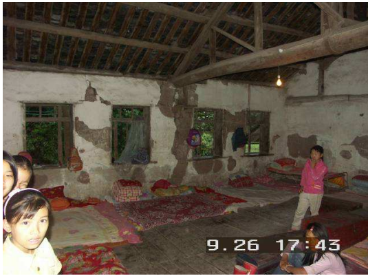
图 5 土坯墙木楼盖学生宿舍
