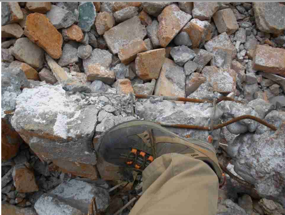
图 5.19 教学楼设置了圈梁，圈梁箍筋间距大约为 200mm，符合抗震规范要求；
