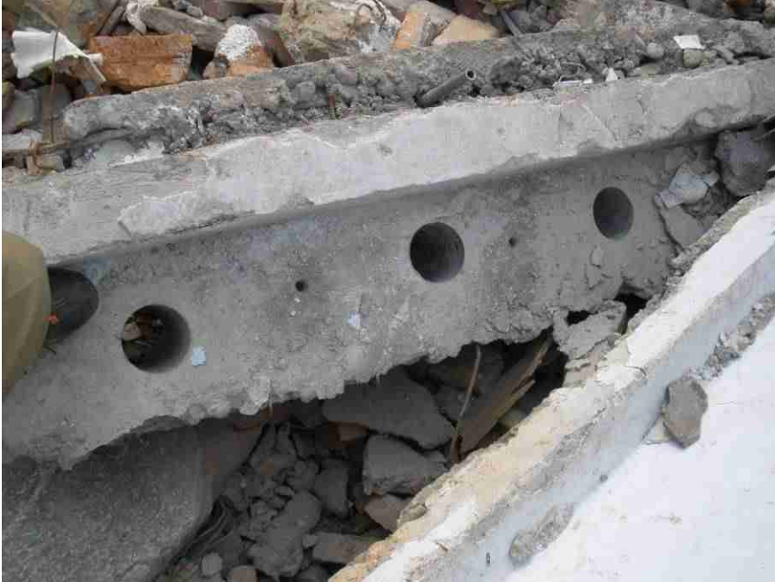
图 5.21 进深梁体上有电钻孔，预制板与二次浇筑层间没有连接
