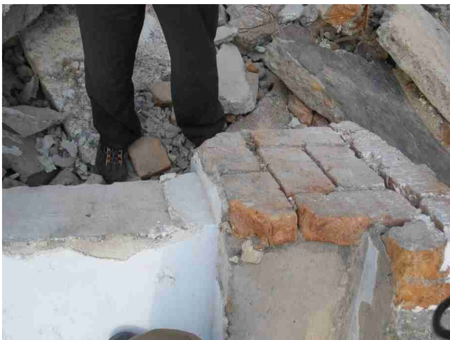
图 5.20 大开间预制进深梁支座处未见连接构造
