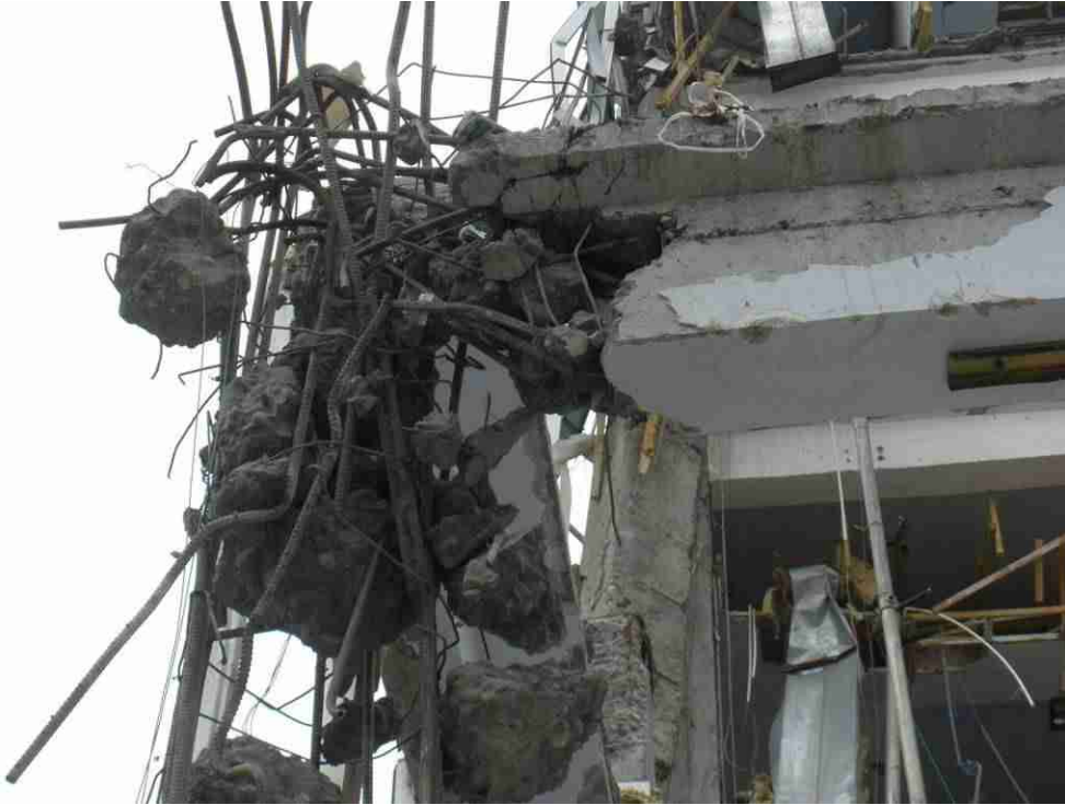
图 5.17 预制框架楼中梁柱节点配筋情况
